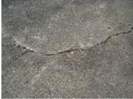
その2. 除草した後、亀裂が大きい場合は、常温合材なので埋めるようにして下さい。
