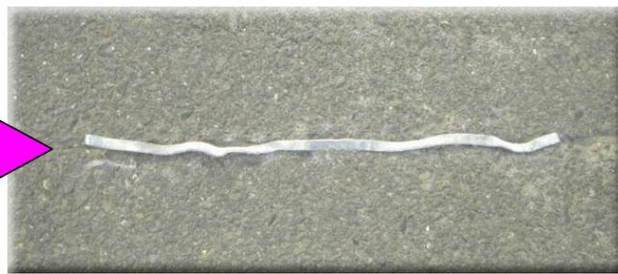
③小型ガスバーナーで溶融させコテで圧入させます。
