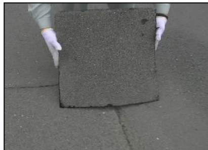
②マットペープの設置
