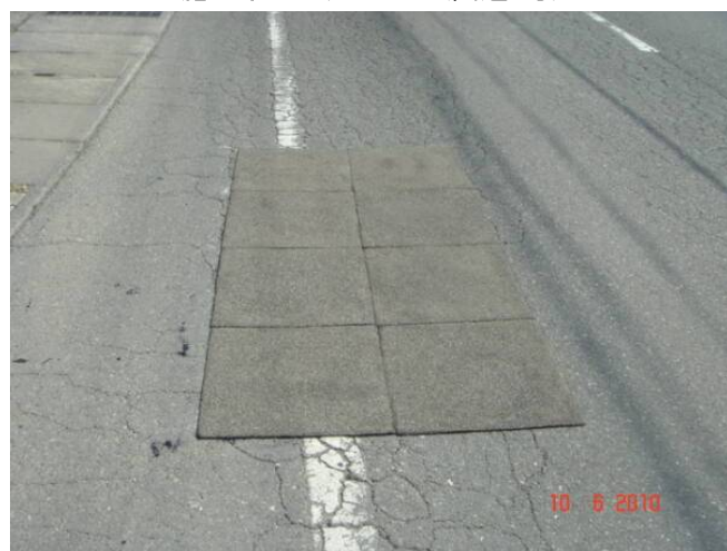
施工後のマットペーパー
