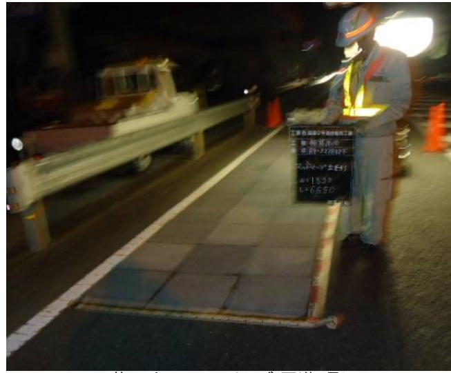
施工中のマットペーパー(国道9号)
