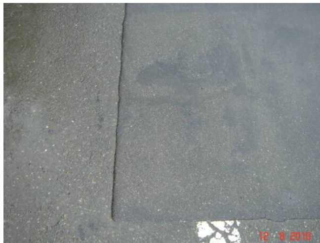
施工3ヶ月端部接着状況
